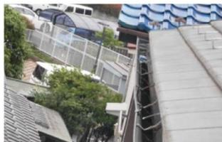
雪災での雨樋の破損
