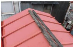
風災での屋根の破損
